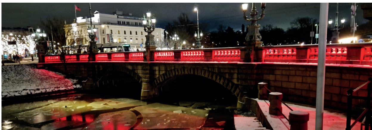
Permanent installerad belysning på Kungssportsbrons förbindelsestråk.
