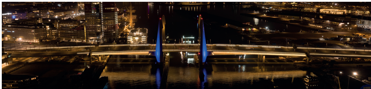
Exempel på fastmonterad säsongsbelysning på Hisingsbron som kan variera utifrån olika tematiseringar.
